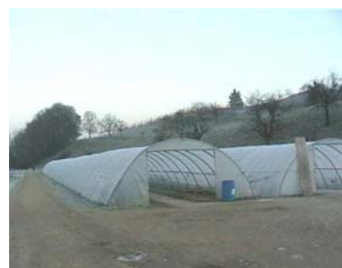
Abbildung 2-5: Folienhaus mit Rundbogenkonstruktion
