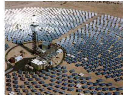
Abbildung 3-7: Spiegelfeld mit zentralem Absorber
