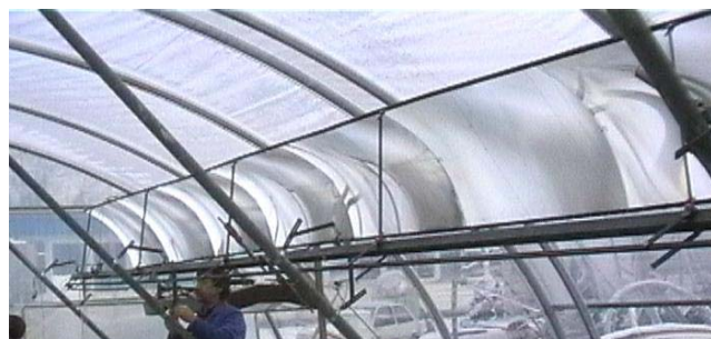
Abbildung 4-11: Montage des ersten Sunray
